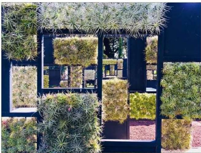
Inserti vegetali a partizione modulare per le pareti verdi a copertura del locale tecnico
